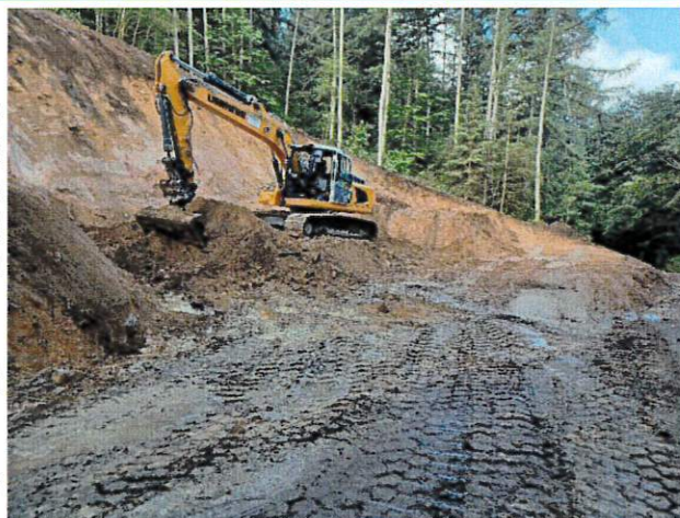
Terrassement station de neutralisation et de désinfection
